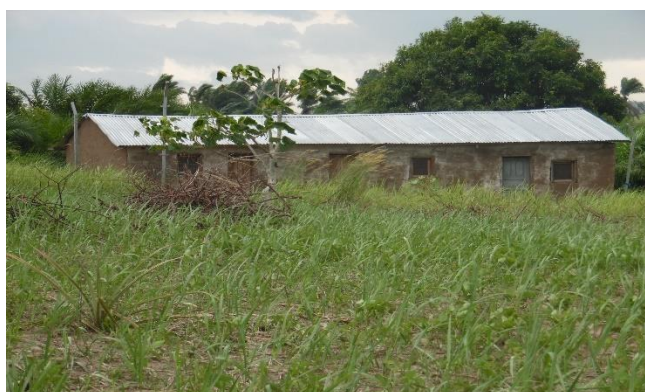
Bâtiment 3 portes pour stockage produits vétérinaires, mini-couvoir et mini vestiaire 8m/4m
