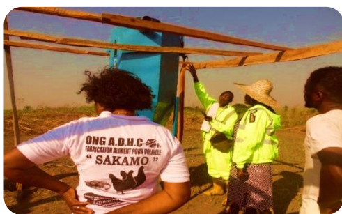
Prise des mesures avant l'installation du mélangeur
